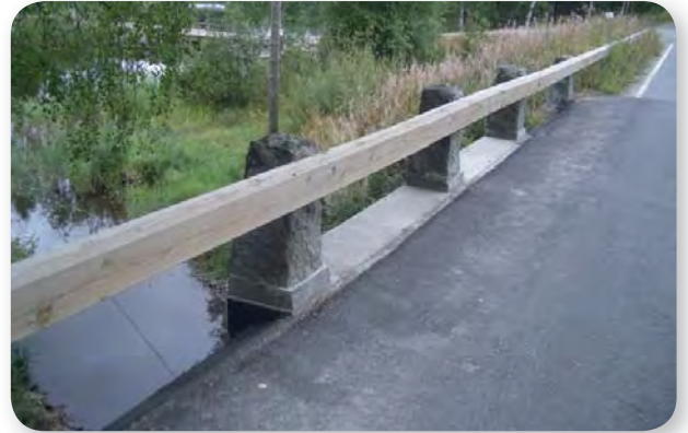
Kuva 49. Porrassalmen ylittävä silta on rakennettu v. 1934 ja sillan kunto on tarkastettu 11/ 2009. Teräsbetonien laattasilta ja kivimuurimaatuet on todettu kunnoltaan hyväksi. Sillan hyötyleveys on 6,10 metriä. Sillan kaide on uusittu ympäristöön hyvin sopivasti puurakenteisena, mutta vastoin voimassa olevia suunnittelumääräyksiä.
