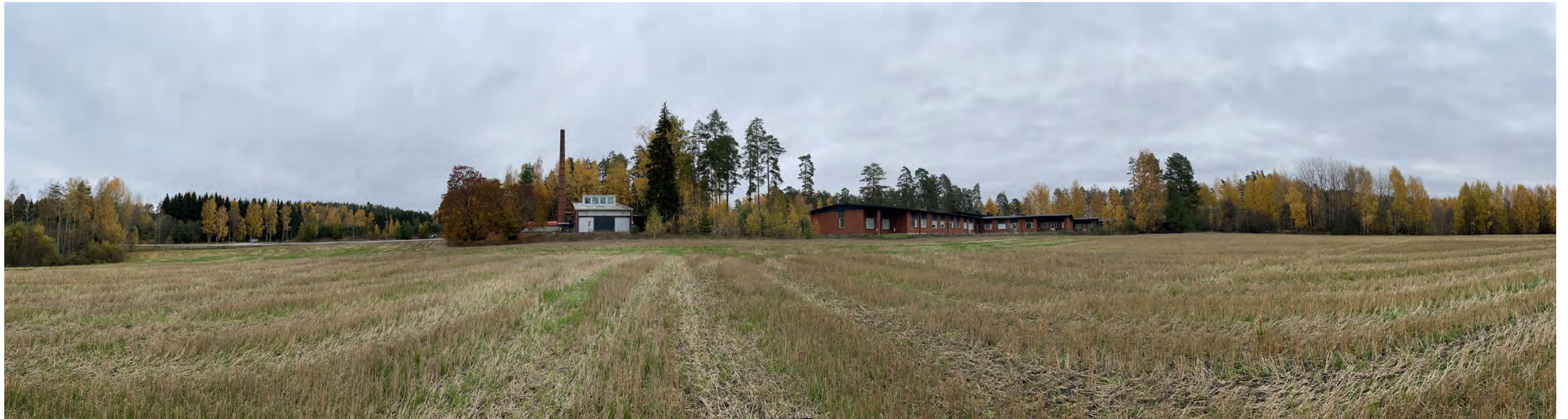
Kuva. Alueen punatiilistä rakennuskantaa peltoalueen reunassa.
