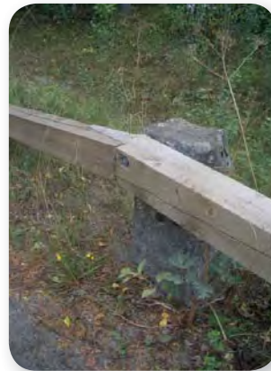
Kuvat 50 ja 51. Porrassalmentiellä on sekä graniittisia että betonirakenteisia tiekaiteita, joissa johde on puuta. Osa johteista on uusittu.
