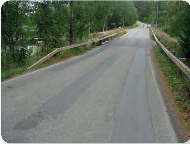
Kuva 29. Näkymä Porrassalmentien sillan kohdalta pohjoiseen
